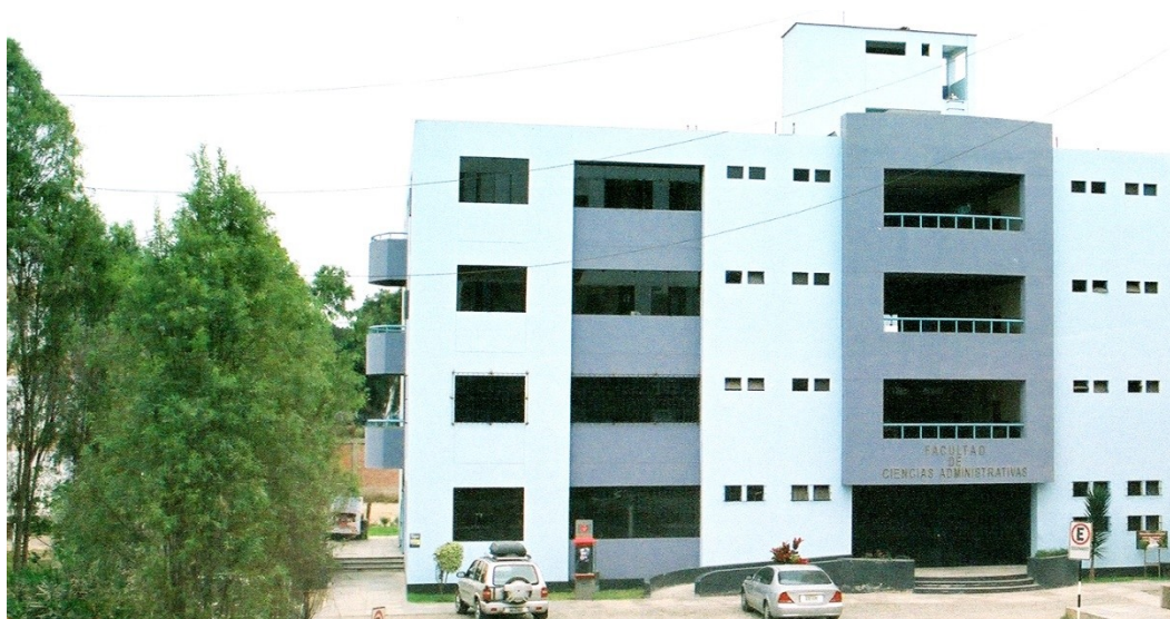
Pabellón de la Facultad de Ciencias Administrativas
